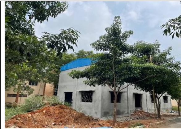
एससीआईईएनटी विस्तार - एनेक्स भवन के निर्माण द्वारा सुविधा का विस्तार।
